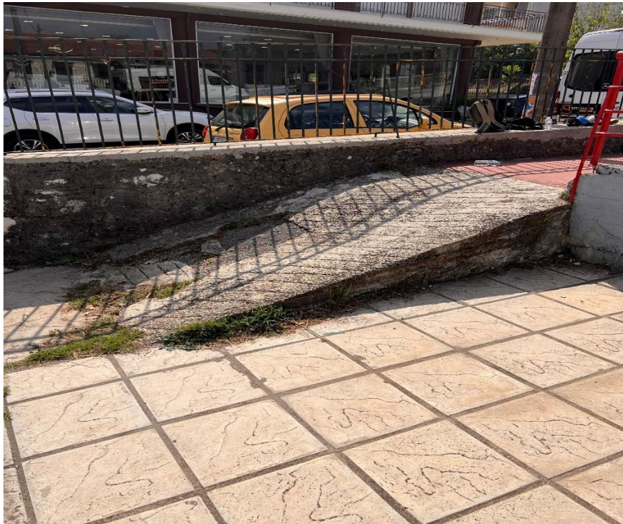
Εικόνα 73: Ράμπα μεταξύ πρώτου και δεύτερου επιπέδου.
