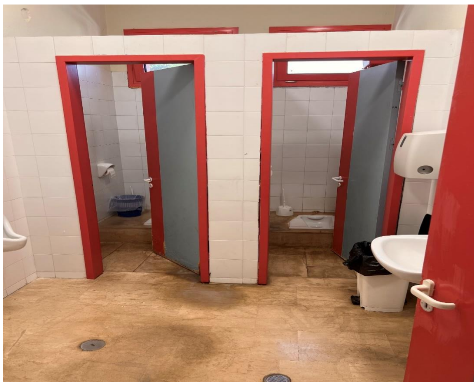
Εικόνα 58: Χώροι υγιεινής Δημοτικού Σχολείου
