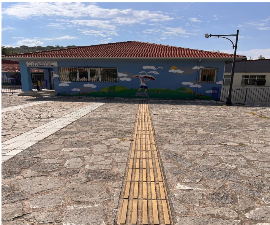
Εικόνα 88: Είσοδος στο σχολικό συγκρότημα μέσω της πλατείας.
