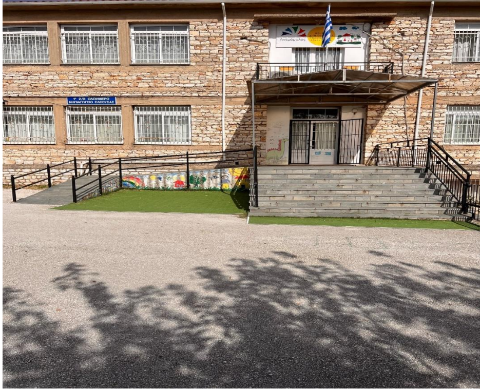
Εικόνα 45: Κατασκευές εισόδου στον χώρο του νηπιαγωγείου.
