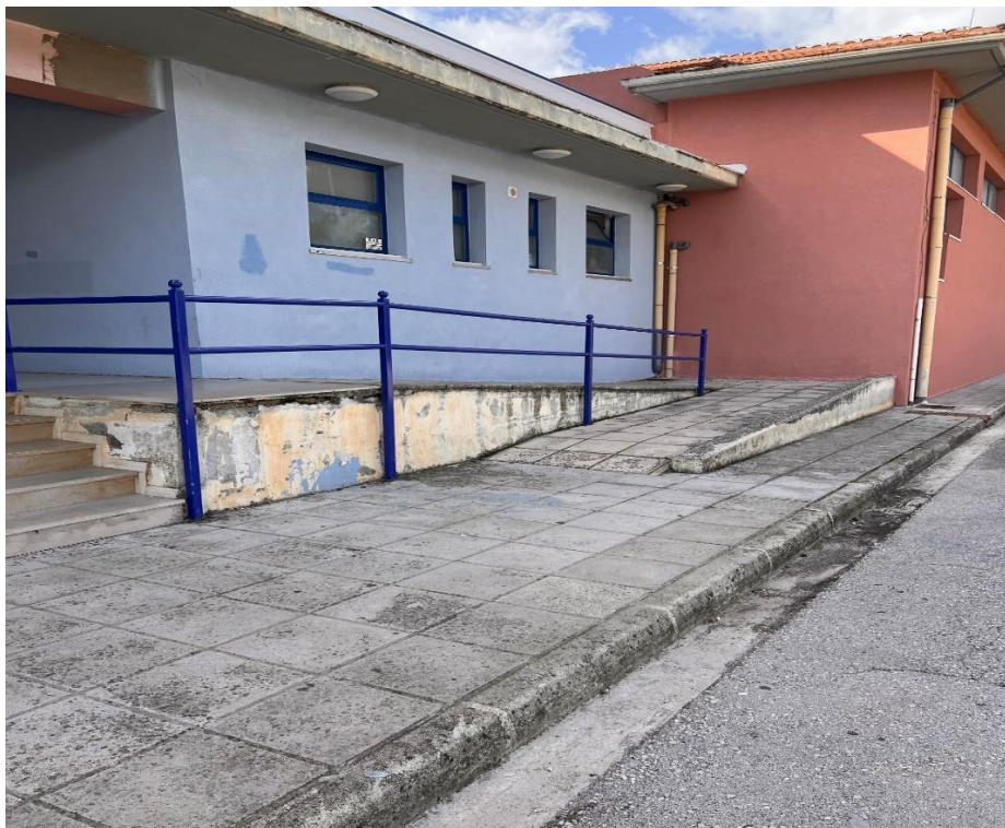
Εικόνα 25: Κατασκευές εισόδου στο κτίριο – Βορειοανατολική πλευρά.
