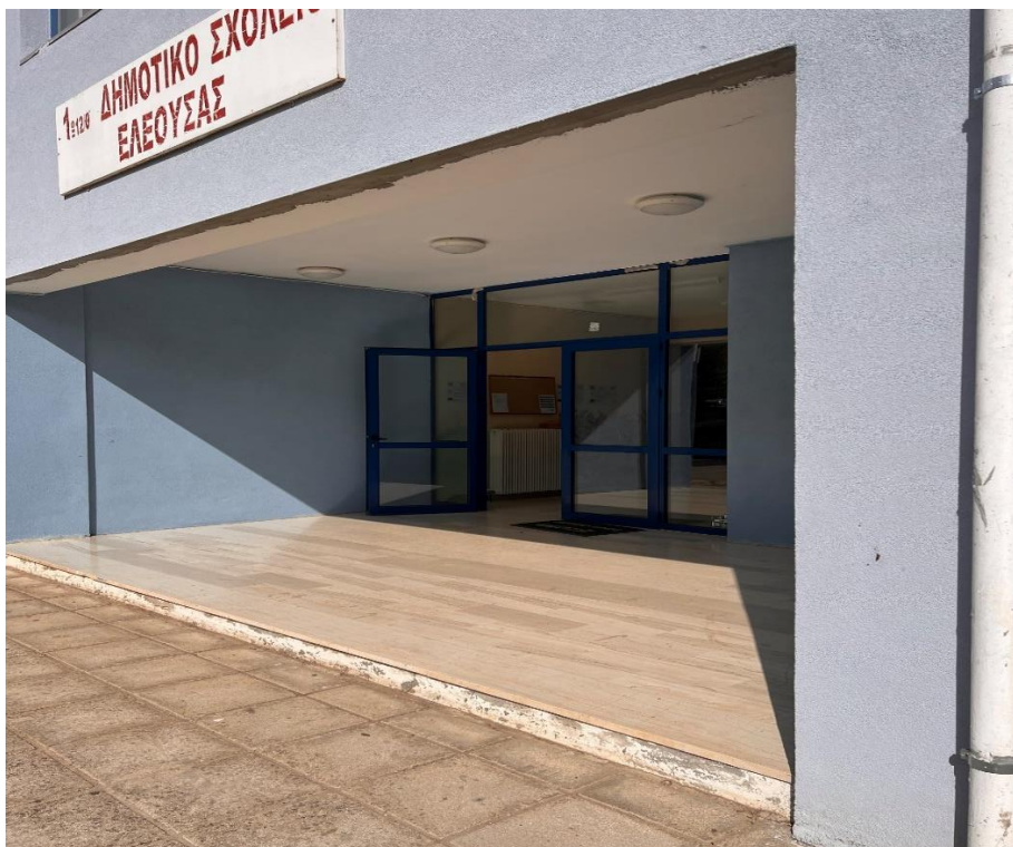
Εικόνα 26: Είσοδος στο κτίριο – Νοτιοδυτική πλευρά.
