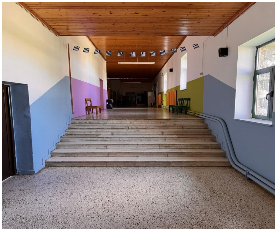
Εικόνα 80: Εσωτερικό κλιμακοστάσιο επικοινωνίας 1 ου & 2 ου επιπέδου.
