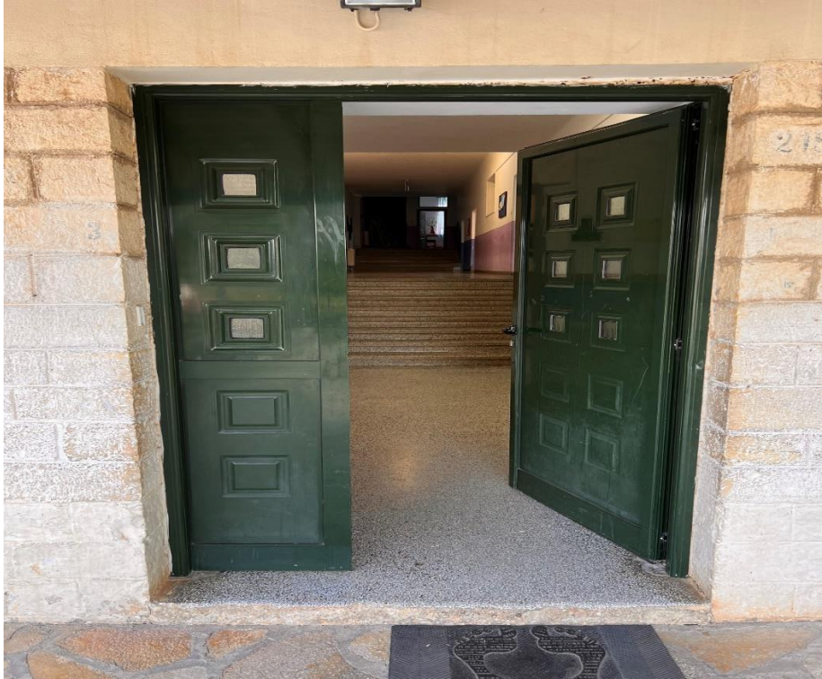
Εικόνα 110: Πόρτα κύριας εισόδου στο εσωτερικό του σχολείου.
