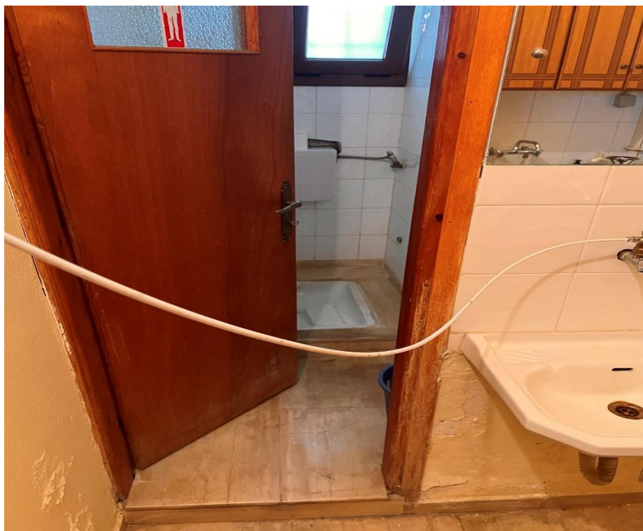
Εικόνα 99: Εσωτερική πόρτα χώρου υγιεινής.
