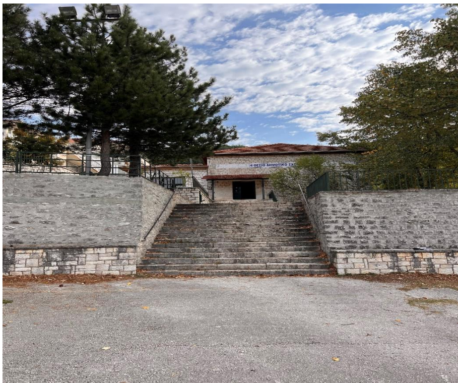
Εικόνα 104: Κλιμακοστάσιο επικοινωνίας 1 ου με 2 ο επίπεδο..
