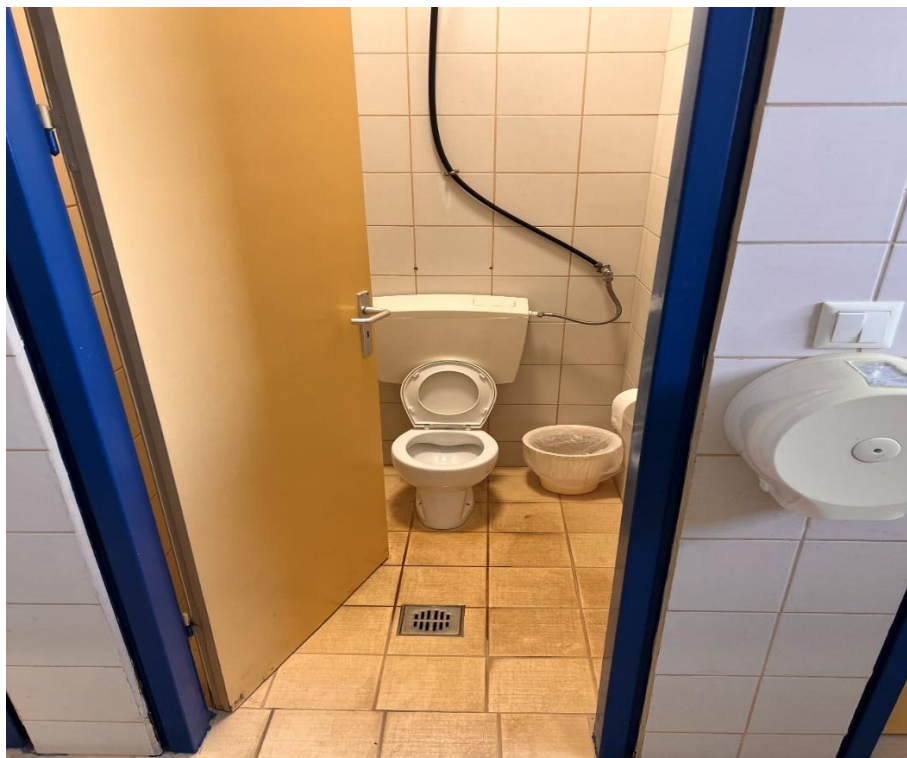
Εικόνα 29: Χώροι υγιεινής νηπιαγωγείου
