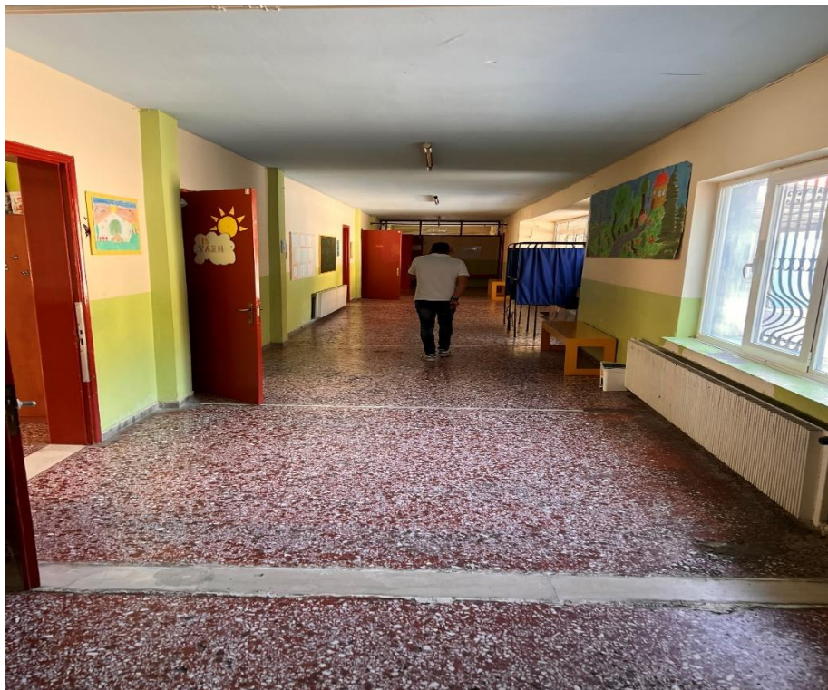
Εικόνα 94: Κατασκευές εισόδου στο κτίριο – Βορειοανατολική πλευρά.
