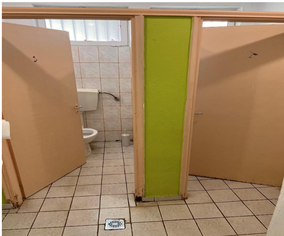
Εικόνα 64: Άποψη από το εσωτερικό του κτιρίου – Χώρος υγιεινής.
