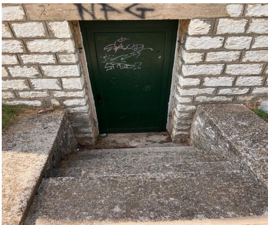
Εικόνα 75: Είσοδος στο εσωτερικό του κτιρίου από την ανατολική πλευρά.
