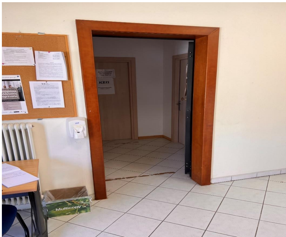
Εικόνα 49: Εσωτερική πόρτα προς αίθουσα εξυπηρέτησης.
